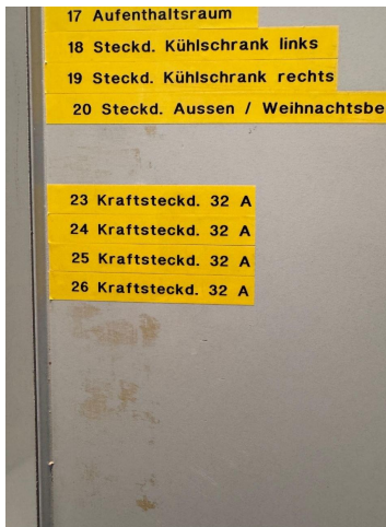
Das Foto zeigt ausschließlich die äußere Beschriftung einer Unterverteilung. Eine sicherheitstechnische Beurteilung der
