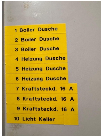
Das Bild zeigt lediglich einen Ausschnitt der Stromkreisbeschriftung auf einer Verteilerabdeckung. Eine sicherheitstechn
