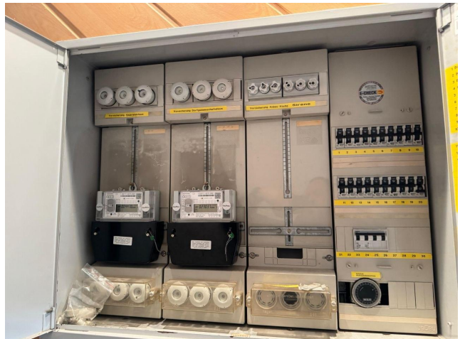
Die Anlage macht einen optisch aufgeräumten, aber älteren Eindruck. Ein E-Check wurde laut Plakette durchgeführt, jedoch
