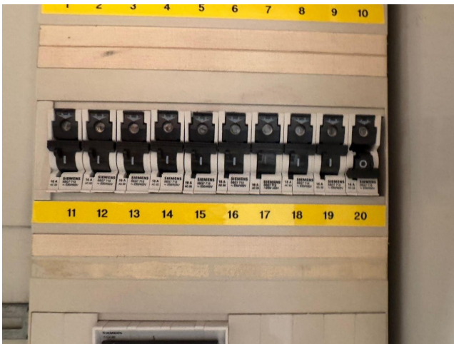
Die sichtbaren Komponenten stammen aus einer älteren Installation. Der fehlende (sichtbare) RCD-Schutz und das Alter der
