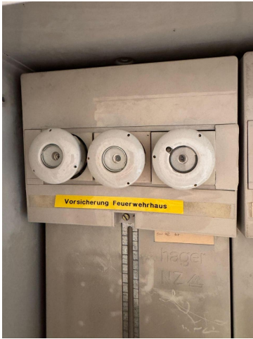
Sichtbar veraltete, aber im Grundsatz funktionsfähige Vorsicherungseinheit in einem stark verschmutzten Zustand. Keine a
