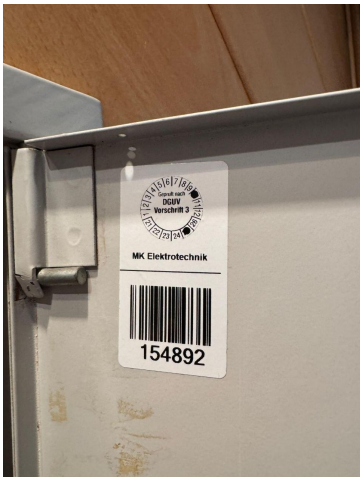
Das Foto zeigt lediglich die Außenseite einer Tür mit DGUV V3 Prüfplakette. Da keine elektrischen Betriebsmittel sichtbar
