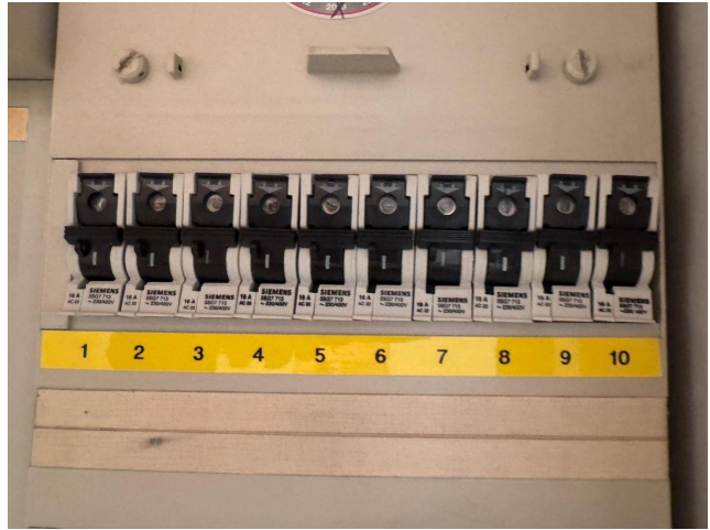
Es handelt sich um eine sehr alte Unterverteilung mit veralteten Leitungsschutzschaltern. Ein zeitgemäßer Personenschutz
